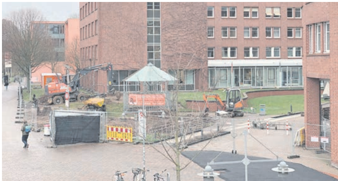
Für die Sanierung werden am Südeingang Pflasterung und Begrünung entfernt.
