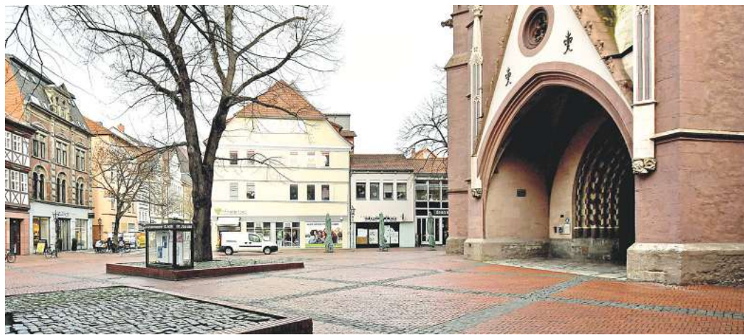
Die Weender Straße und der Jacobi-Kirchhof sind in diesem Bereich ober- und unterirdisch in die Jahre gekommen. Foto: Christina Hinzmann
